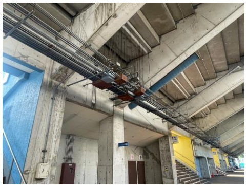
⑤【コンコース】老朽化による漏水や腐食が目立つ
