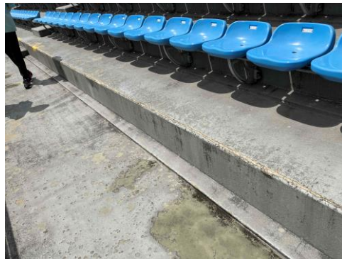
②【メインスタンド】段床部分が劣化し亀裂が発生（修繕済）
