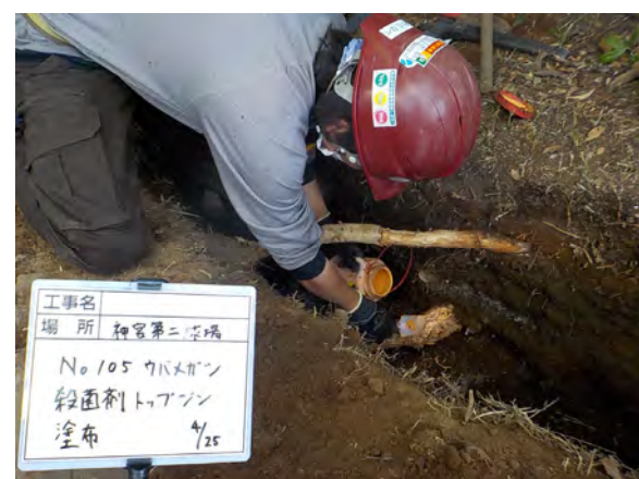
写真 1-5 癒合剤（殺菌剤）の塗布状況
