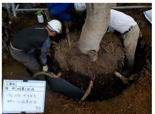
写真 1-6 畦シートの設置状況
