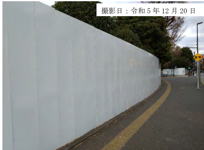
写真 2-1 仮囲い（高さ 3.0m）の設置状況
