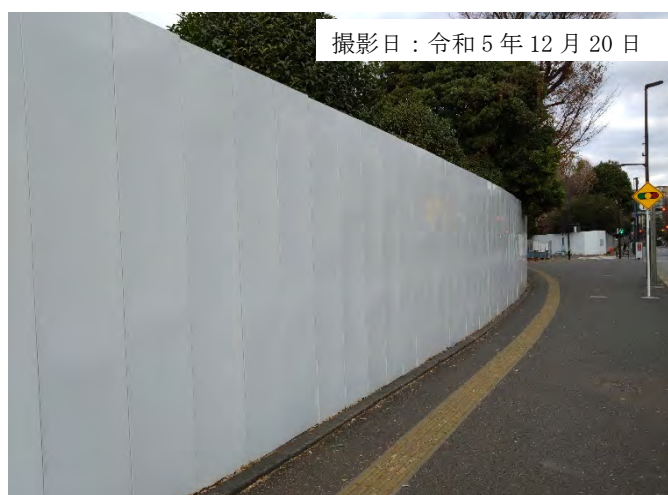
写真 1-3 仮囲い（高さ 3.0m）の設置状況
