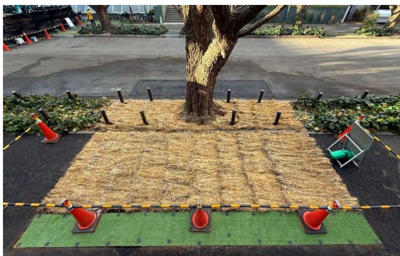
写真 4-6 調査樹木保全の状況（樹木 No. 15（南側列））
