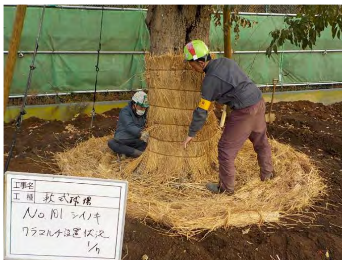
稲ワラ敷設状況
