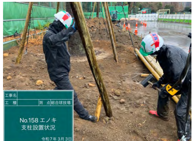
写真 1-2 樹木支柱等の状況（参考写真）
