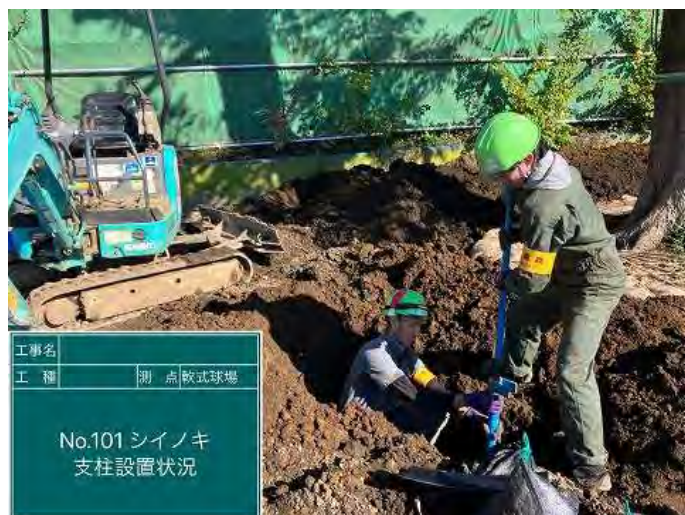
アンカー支柱設置状況
