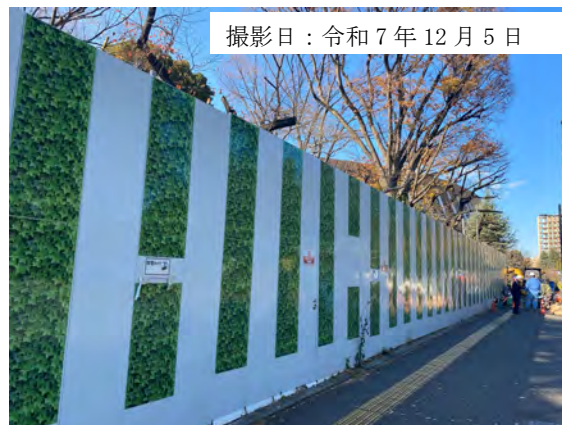
写真 5-1 仮囲い（高さ 3.0m）の設置状況
