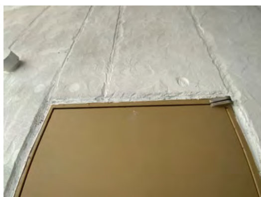
写真 4-1 アスベストの飛散防止剤塗布状況
